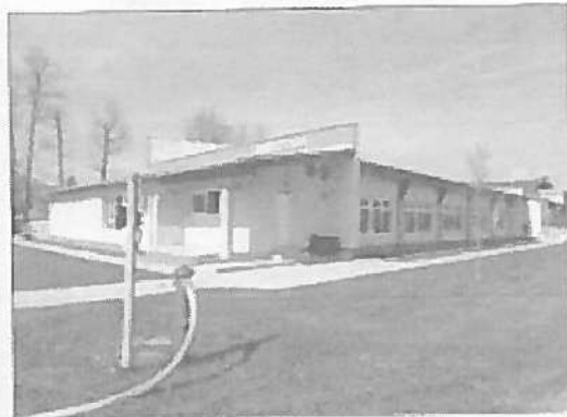
Homlokzat (büfé terasz)
